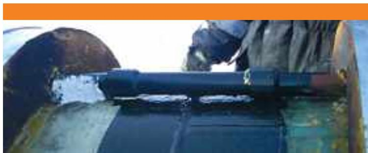
Рис. 8. Заполнение зазора между скин-нагревателем и транспортной трубой теплопроводящей пастой Silarm белого цвета.
